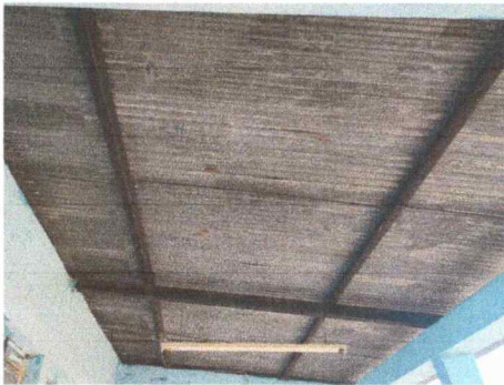
Foto 3: sustitucion de laminas por troqueladas
