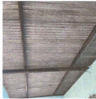
Foto 4: mantenimiento de costaneras
